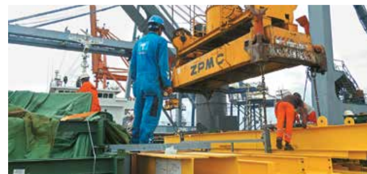
Os equipamentos para o Estaleiro vieram no Thorco Legend, que saiu do Japão todo dedicado ao empreendimento.
