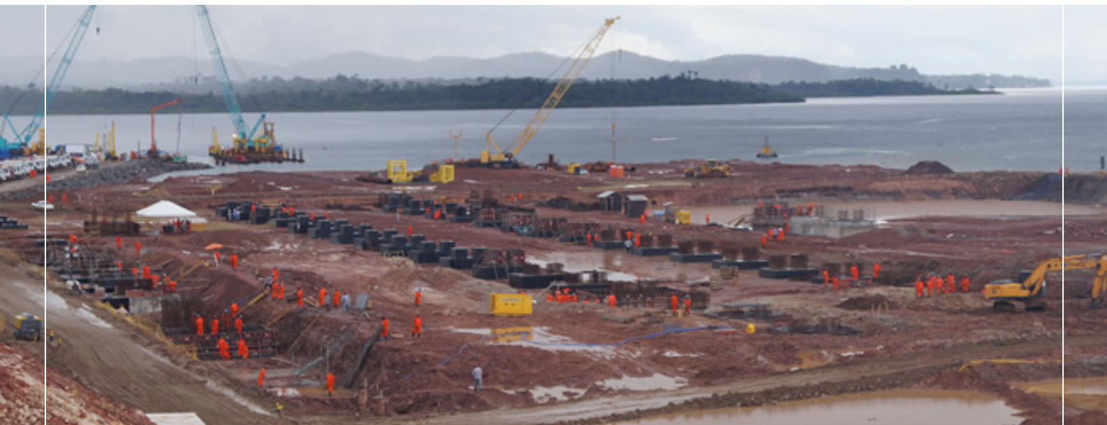
Registro do canteiro de obras do EEP em Enseada, região de Maragojipe, no Recôncavo Baiano. Em 19/06/2013.
